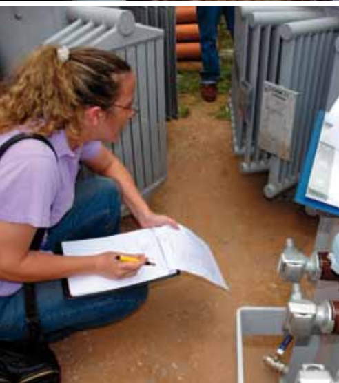
Inventario de transformadores en el Paraguay
