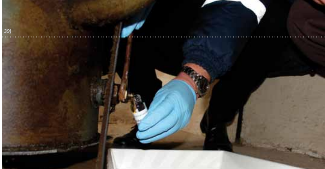
Toma de muestra de la válvula inferior con bandeja colectora
