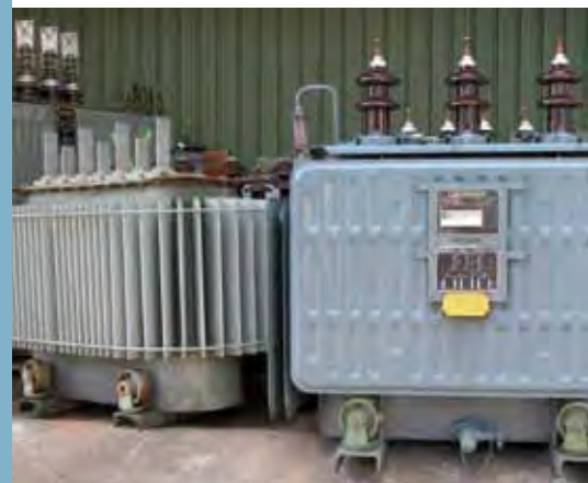
Desmontaje de un transformador con PCB
