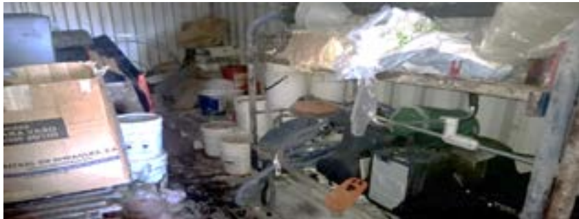
Figura 40. Espumas contra incendios almacenadas en contenedor convertido en bodega en Puerto Quetzal
