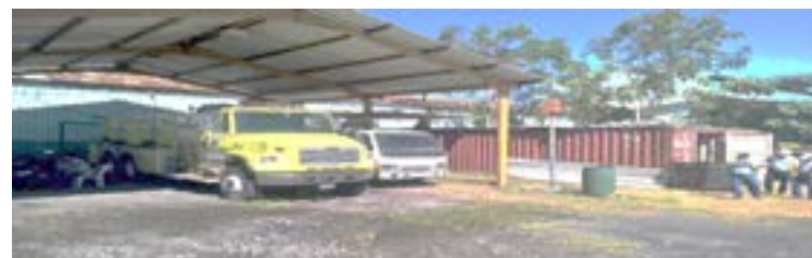
Figura 44. Estación de bomberos de Puerto Quetzal
