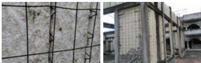
Figura 39. Uso del poliestireno expandido posiblemente contaminado con HBCD en la construcción
