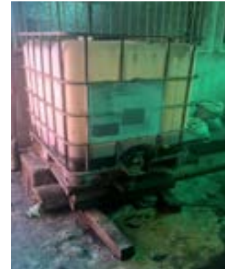
Figura 42. Tote de espumas vencidas trasvasadas que presenta derrames en la Estación Central de Bomberos Voluntarios, zona 3 de la Ciudad de Guatemala
