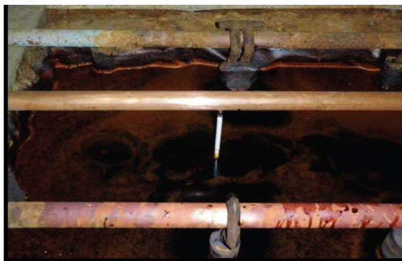
Systeme de suppression de fumee à base de SPFO
